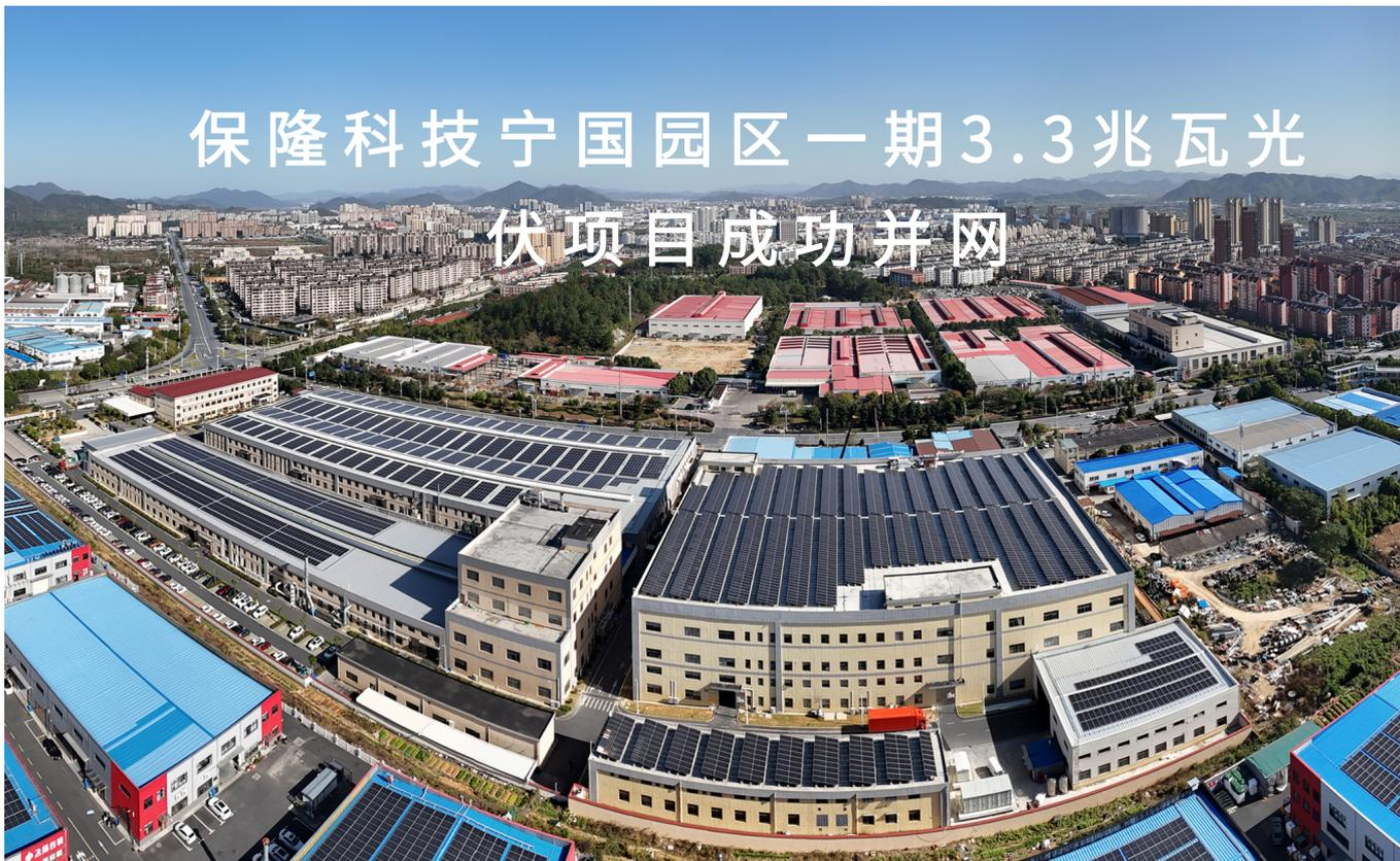
11月25日，保隆科技宁国园区一期3.3兆瓦光伏项目顺利验收，光伏矩阵一次并网成功，标志着该项目成功并网发电，开始向园区电网送出“绿电”。项目采取“就近接入、自发自用、余电上网”的方式，充分利用拓扑思厂区3万平方米厂房屋顶实施建设。
